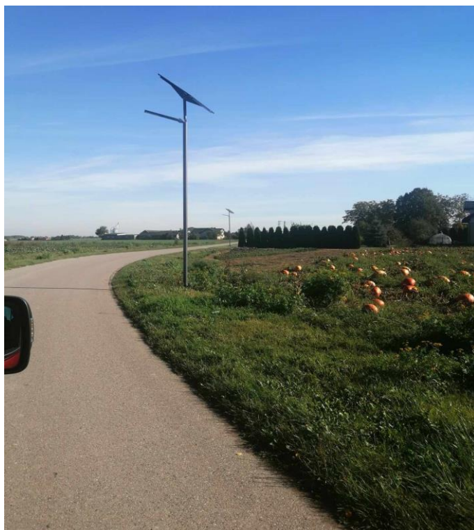
Oświetlenie uliczne solarne w miejscowości Srebrna
